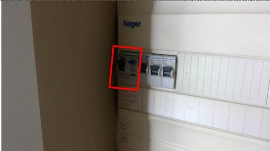
Description : Au moins un dispositif de protection différentielle ne fonctionne pas pour son seuil de déclenchement.
